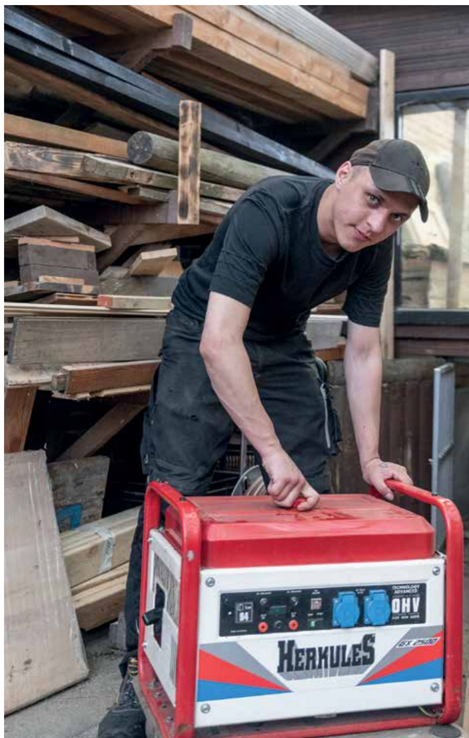
Einen Stromanschluss gibt es nicht, deshalb wird sich mit einem Generator beholfen. Tim weiß, wie er zu bedienen ist.
